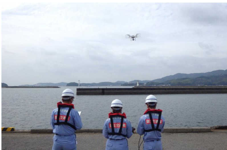
ドローンによる港湾施設点検
