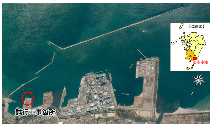
試行工事場所(志布志港)
