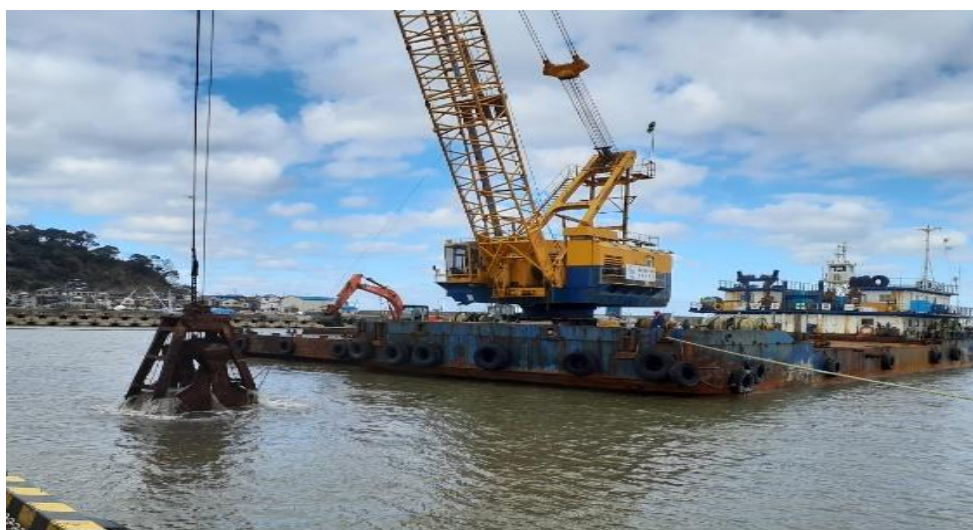
浚渫作業の様子（輪島港）
