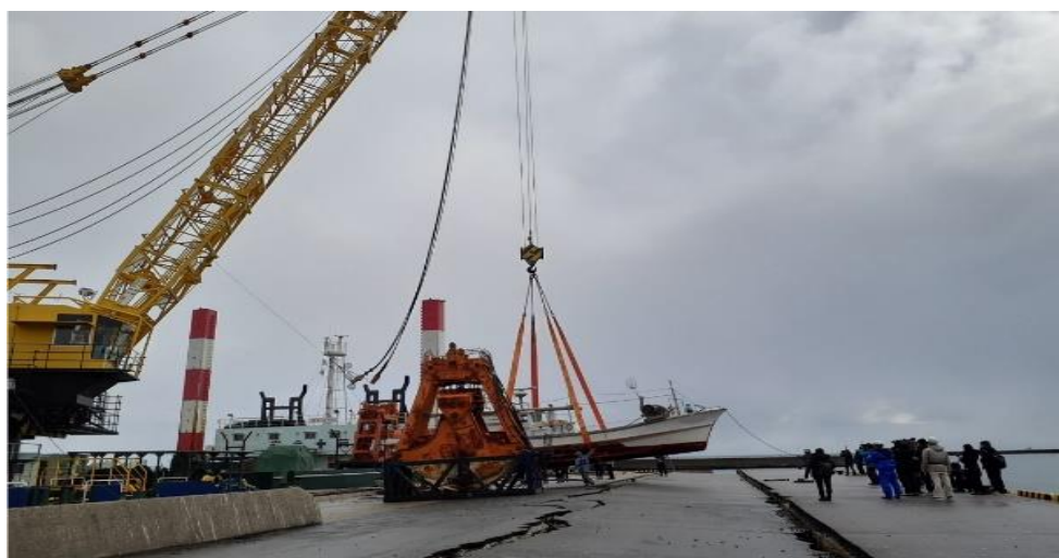
引揚げ作業の様子（飯田港）
