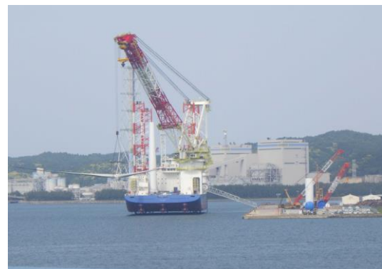
風車羽を積み込み中
