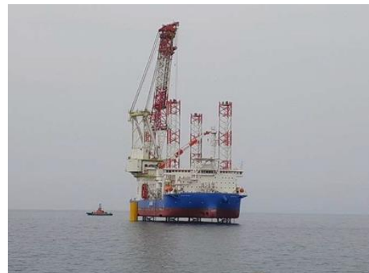
入善町沖で風車支柱設置
