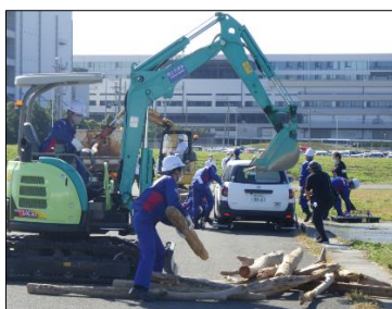
バックホウによる道路啓開訓練 (津波漂流物撤去)
