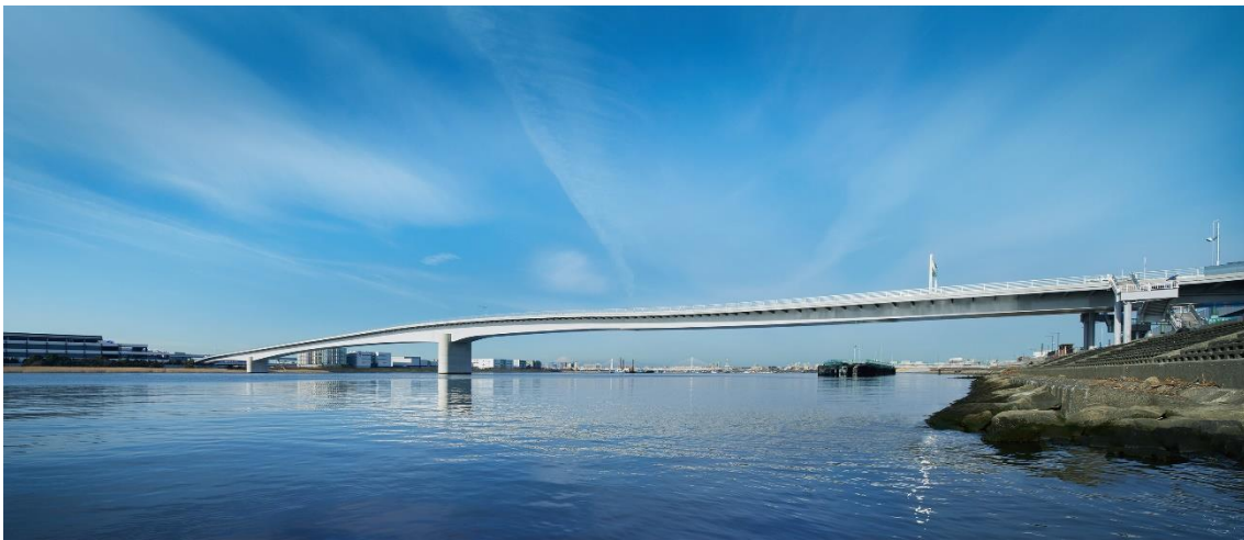
多摩川スカイブリッジ全景
