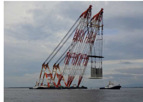
起重機船「海翔」による 大型ケーソンの運搬
