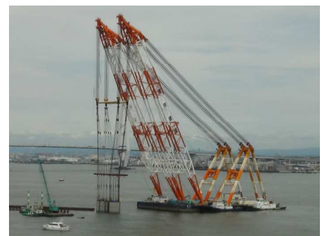
大型ケーソンの据付状況
